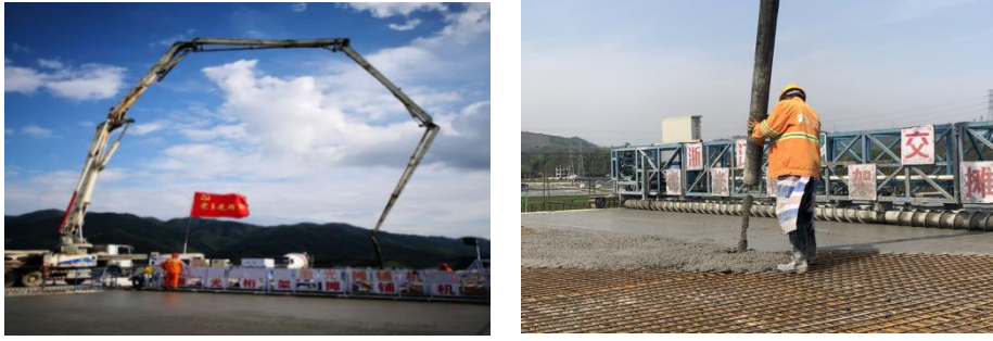
图 37 布料泵车作业示意图
