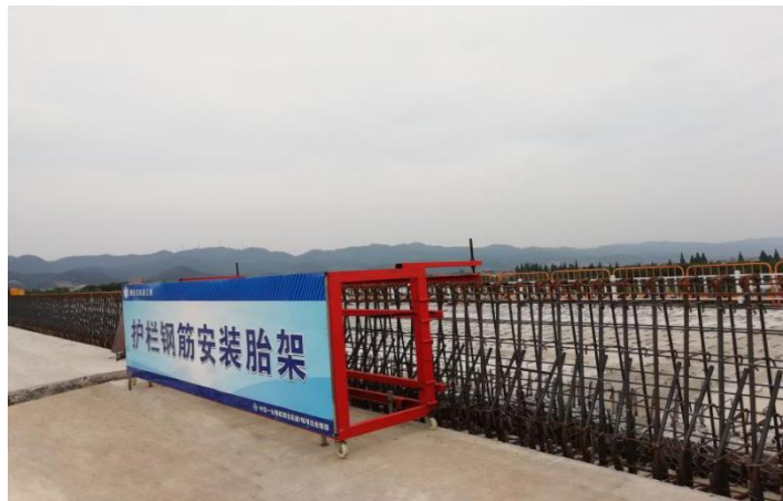
图 6 定位胎架作业示意图
