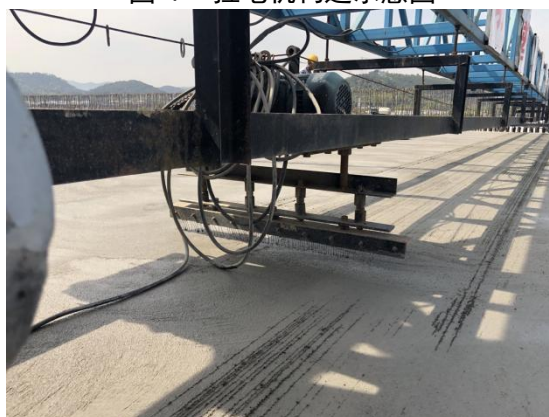
图 9 拉毛机构造示意图
