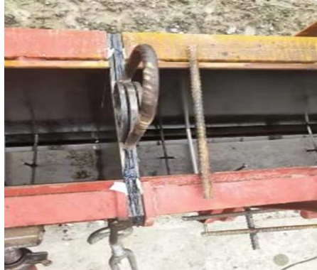
图54 施工缝钢塞板示意图
