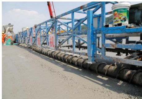
图 38 整平与振捣作业示意图
