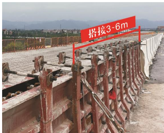
图 55 护栏模板预留搭接示意图
