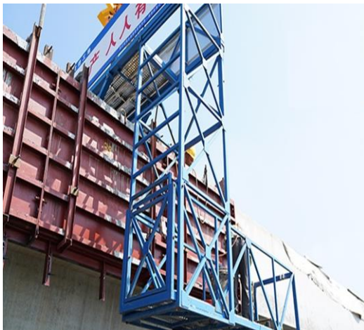
图 18 作业台车作业示意图 1
