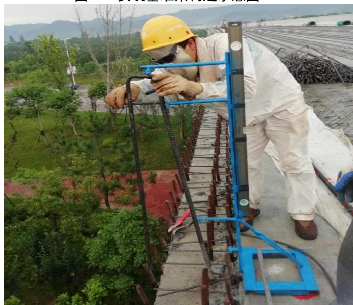
图 4 安装基准架作业示意图
