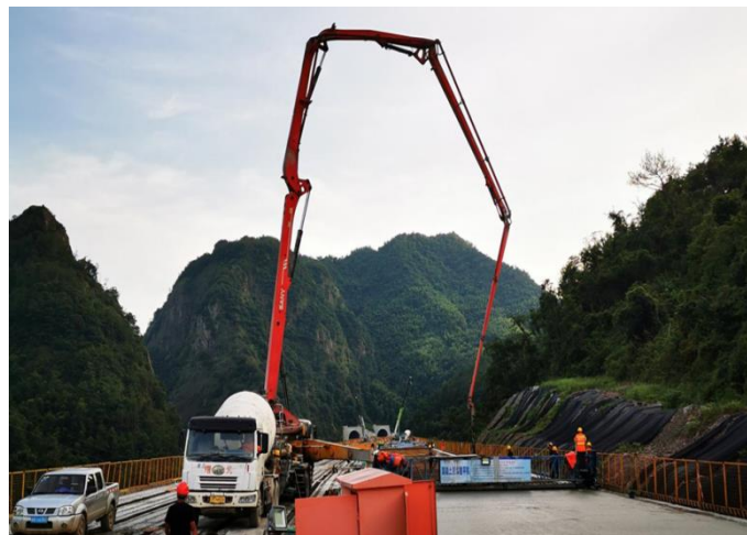
图 4 布料泵车桥面作业示意图
