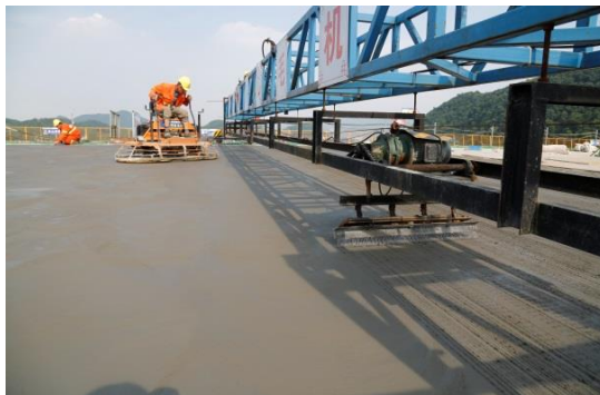
图 40 拉毛机作业示意图
