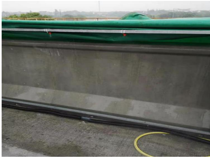
图 27 智能养护系统作业示意图（自动喷淋）
