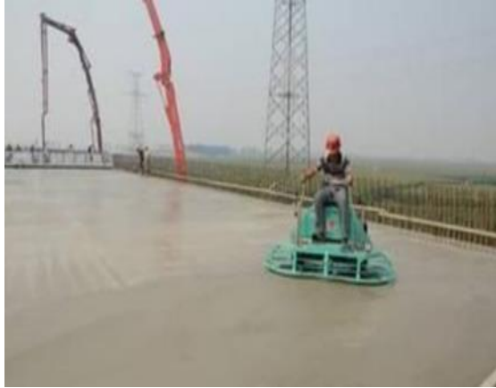
图 39 抹面机作业示意图
