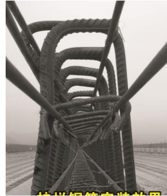
图 48 护栏钢筋安装效果示意图
