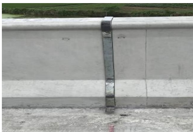
图 56 切缝定位架示意图
