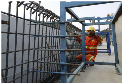
图 49 定位装置示意图（建议补充）
