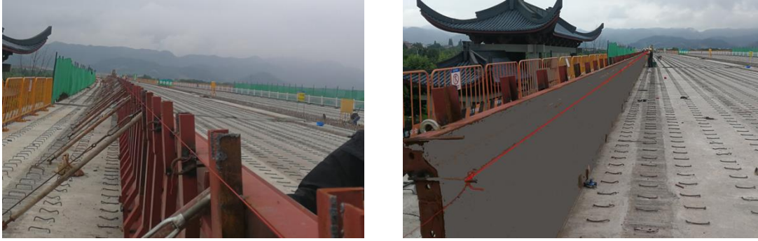
图 50 模板整体拼装示意图
